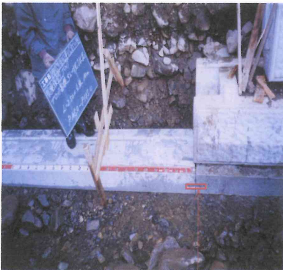
基礎盤の固定
