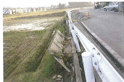
小千谷市若葉団地(道路擁壁)
