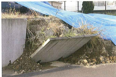
小千谷市若葉団地(宅地擁壁)
