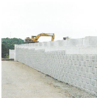
補強土壁（ジオグリット）
