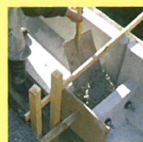
コンクリート打設状況
