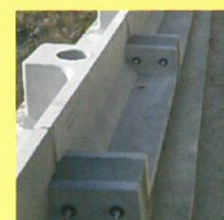
間詰めコンクリート完了
