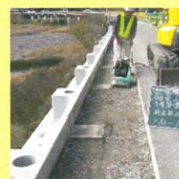
埋戻し、路盤工施工
