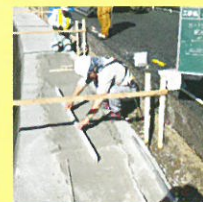
敷きモルタル
