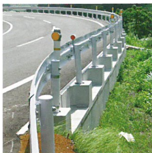
L型擁壁（天幅前面に合わせた例）
