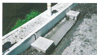
③ 底版上の土を取り除いた状況
