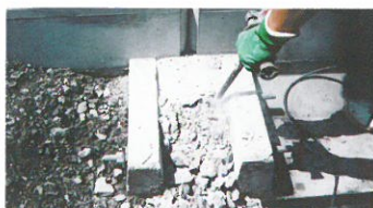
④ 間詰めコンクリート除去
