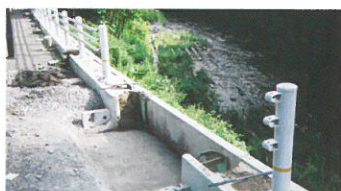
⑤ 製品を撤去した状況
