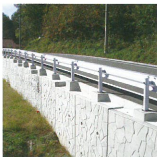
L型擁壁（天端部分を外した例）
