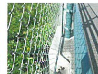
補修した近景
