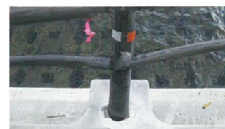
横断方から見た状況
