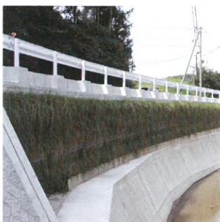
ジオテキスタイル補強土壁
