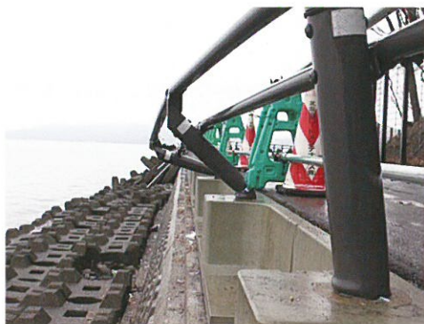
横方向から見た状況
