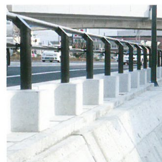
大型ブロック積擁壁
