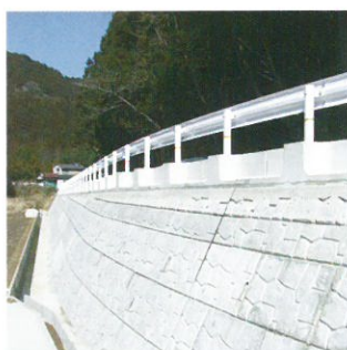
大型ブロック積擁壁
