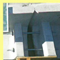
連結筋設置完了
