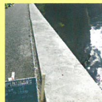
均しコンクリート
