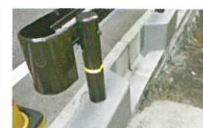
補修した2本の近景
