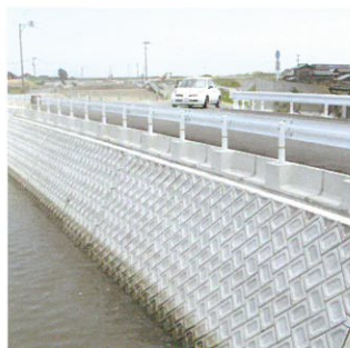
間知ブロック積擁壁
