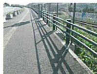
補修した後の全景
