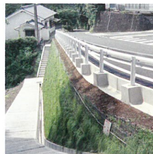
ジオテキスタイル補強土壁
