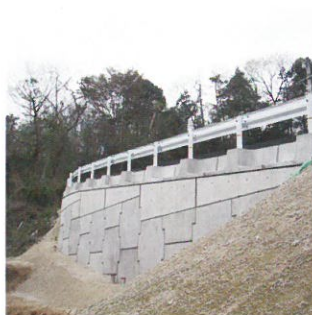
補強土壁（スーパーテールアルメ）
