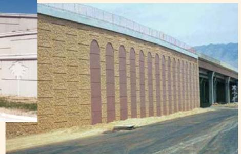
※壁高が10m以下の適用で、幅広ストリップの「最適配置」・「最適長さ」が存分に発揮されます。
